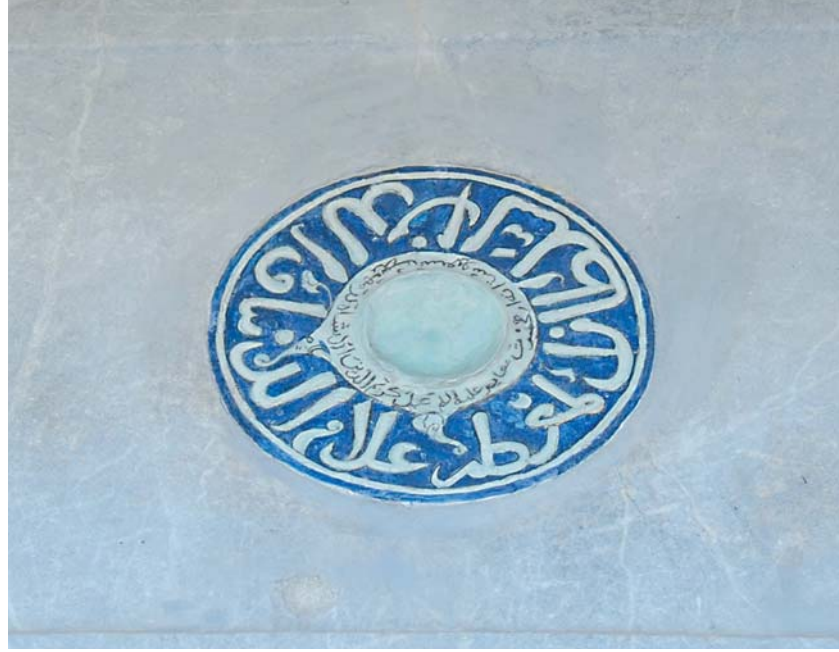
Fotoğraf: Batı Cephedeki Üçüncü Kapıda Bulunan Kerimüddin Erdişah Kitâbesi Photo: Inscription of Kerimuddin Erdishah, above the Third Door on the Western Façade
