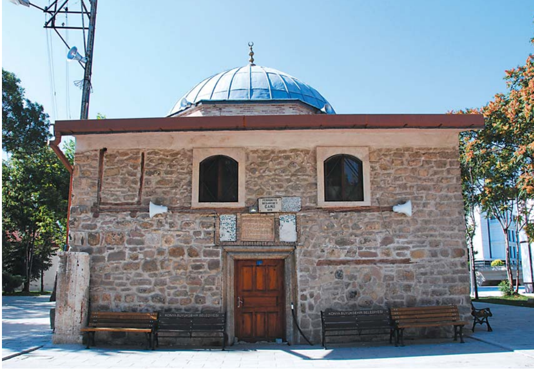
Başarabey Mescidi Genel Görünüm / Başarabey Mosque, General View
