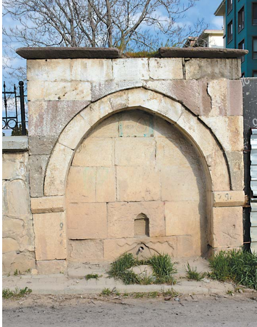
Dolap Çeşmesi Genel Görünüm / Dolap Fountain, General View
