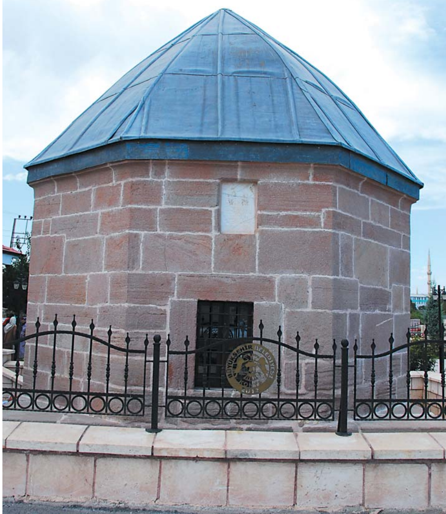
Ateşbâz-ı Velî Türbesi Genel Görünüm / Ateşbâz-ı Velî Tomb, General View
