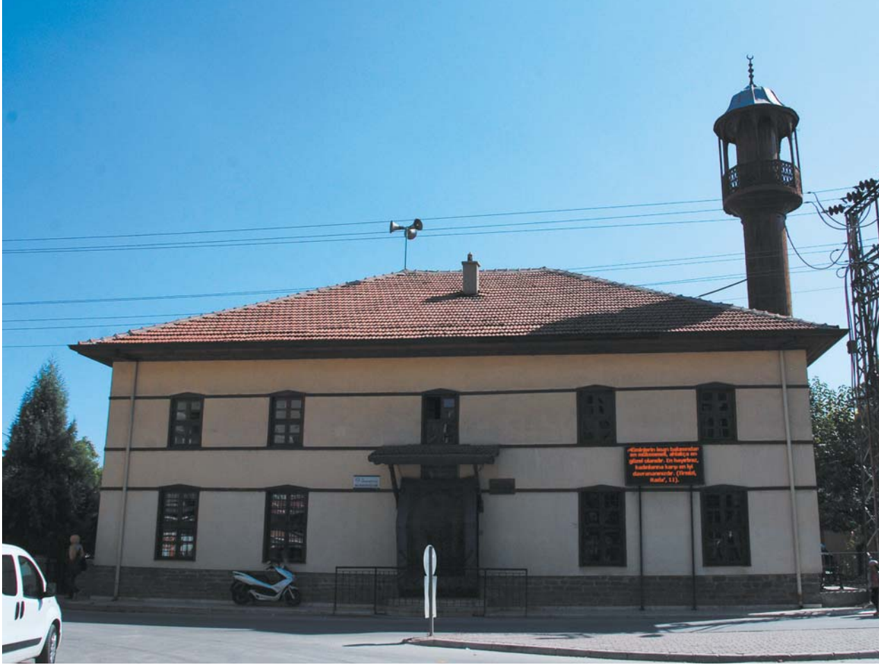
Hacı Mustafa Ağa Camii Genel Görünüm / Hadji Mustafa Aga Mosque, General View
