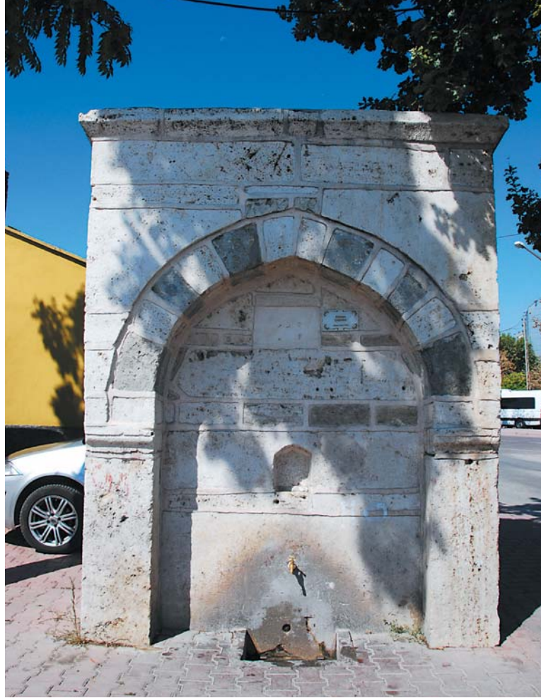
Ali Paşa Çeşmesi Genel Görünüm / Ali Pasha Fountain, General View
