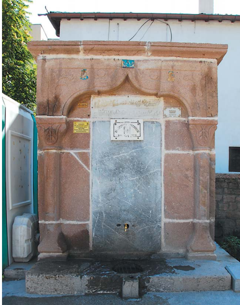
Ferhuniye Çeşmesi Genel Görünüm / Ferhuniye Fountain, General View
