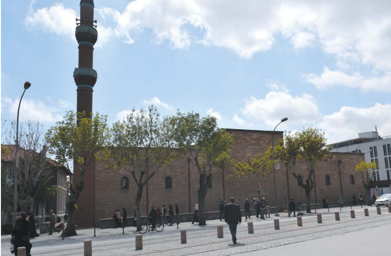
İplikçi Camii Genel Görünüm / Iplikci Mosque, General View
