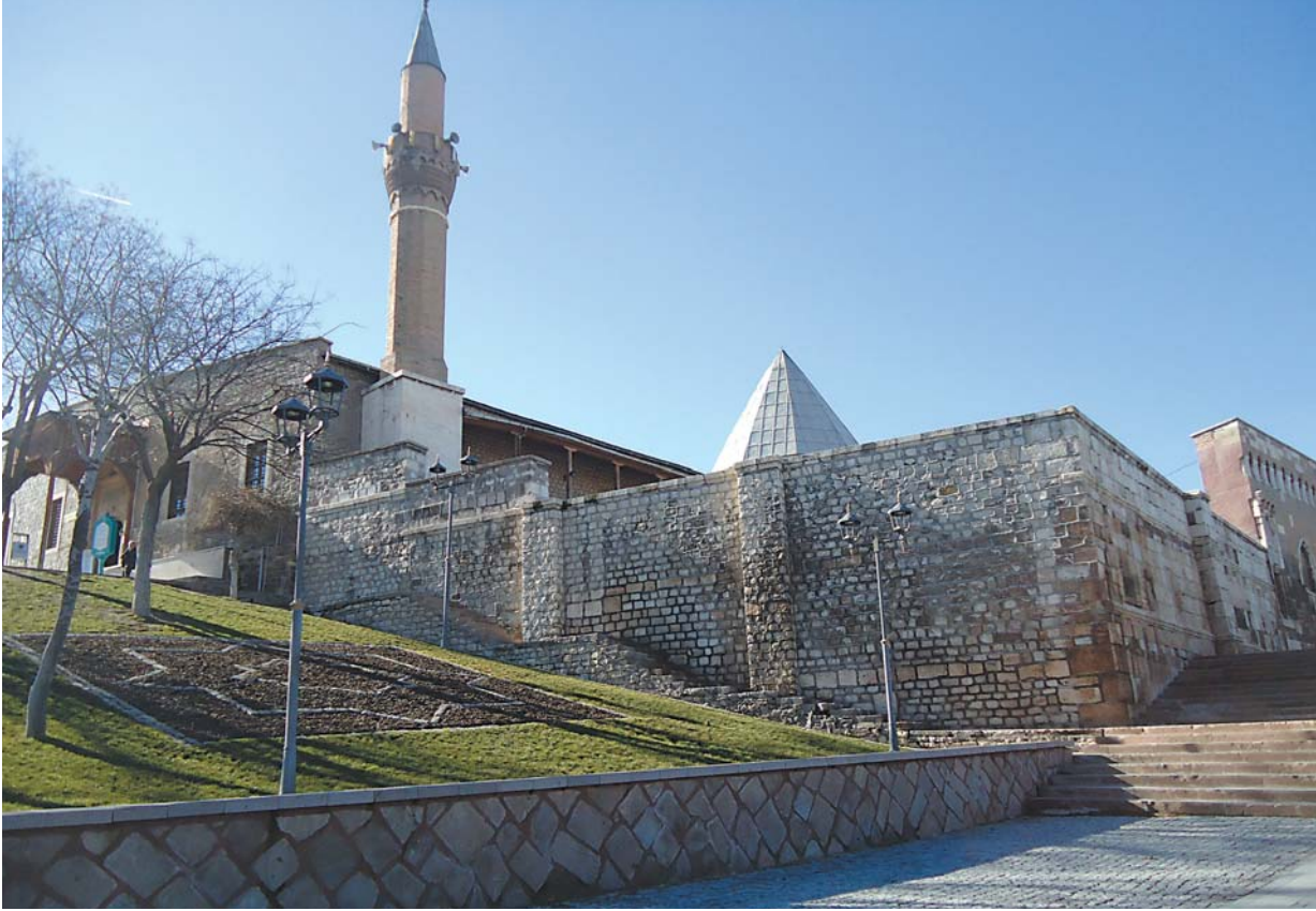
Alaaddin Camii Genel Görünüm / Alaeddin Mosque, General View
