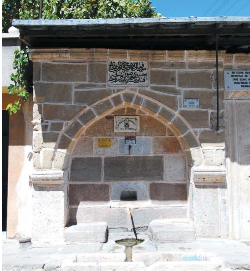
Hacı Fettaf Çeşmesi Genel Görünüm / Hadji Fettaf Fountain, General View
