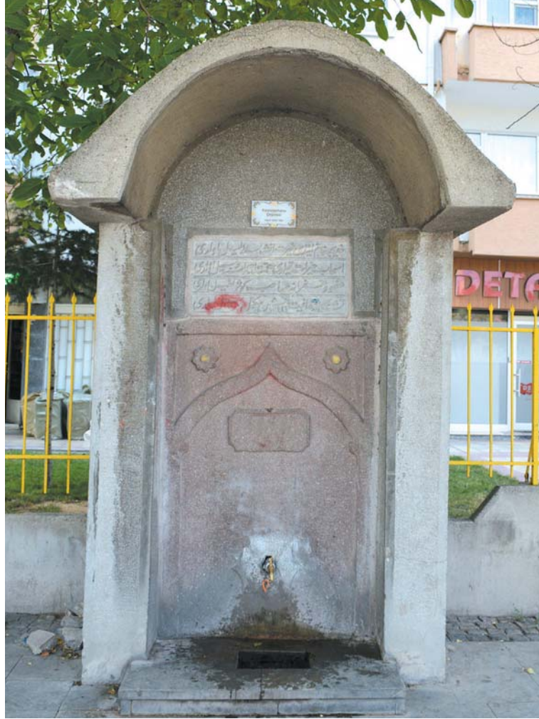
Kalenderhane Çeşmesi Genel Görünüm / Kalenderhane Fountain, General View
