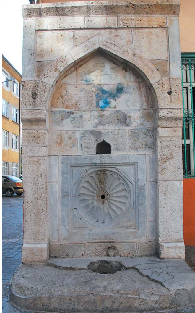
Baba Sultan Camii Çeşmesi Genel Görünüm / The Fountain of Baba Sultan Mosque, General View
