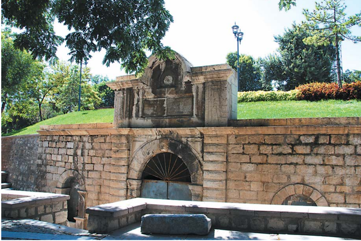
Ferid Paşa Su Deposu Genel Görünüm / Ferid Pasha Cistern, General View
