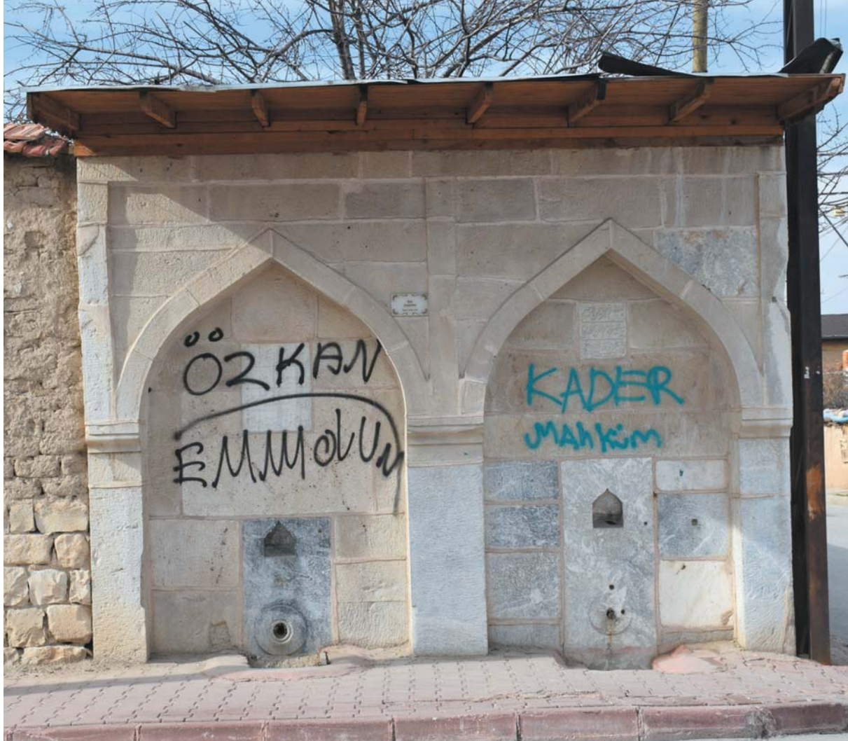
İkiz Çeşme Genel Görünüm / İkiz (Twin) Fountain, General View
