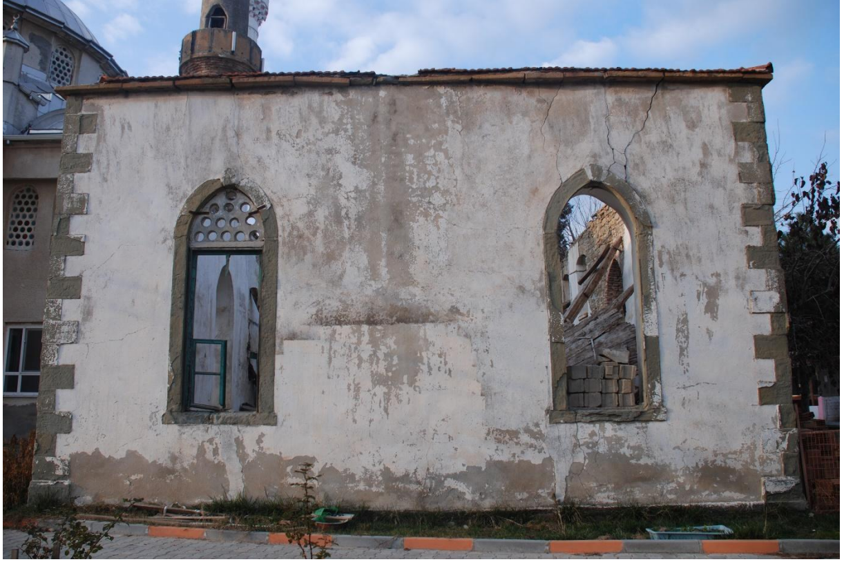
Res. 4: Koyunyeri Köyü Camii, Güney Cephesi
