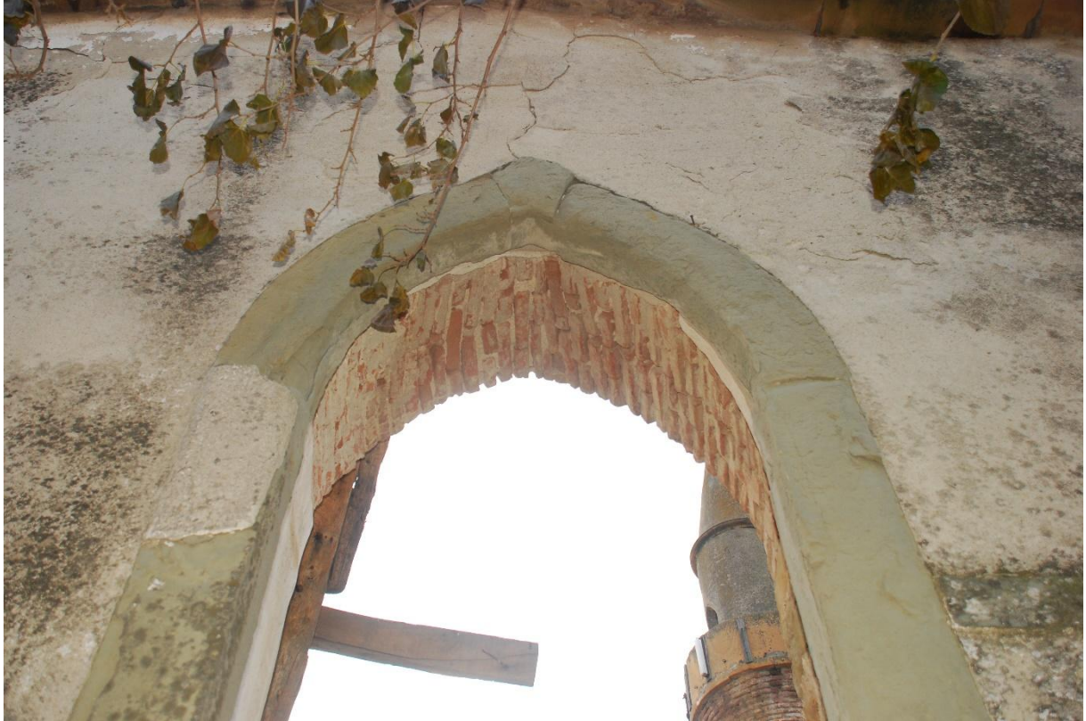
Res. 3: Pencerelelerin Kemer Karnında Tuğla Kullanımı
