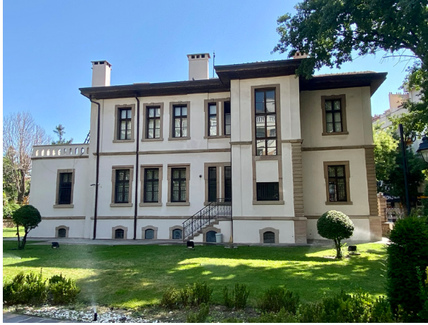
Fotoğraf 13: Atatürk Evi Batı Cephesi Genel Görünüm / Photo 13: General View of the Western Facade of the Atatürk House
