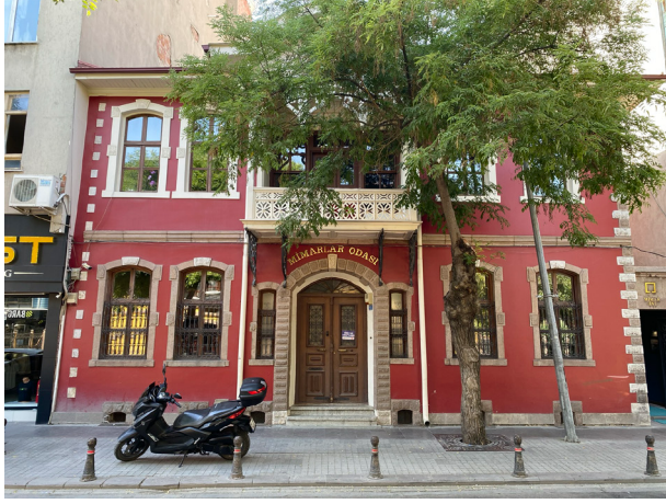
Fotoğraf 37: Mimarlar Odası Binası Genel Görünüm / Photo 37: General View of the Chamber of Architects Building
