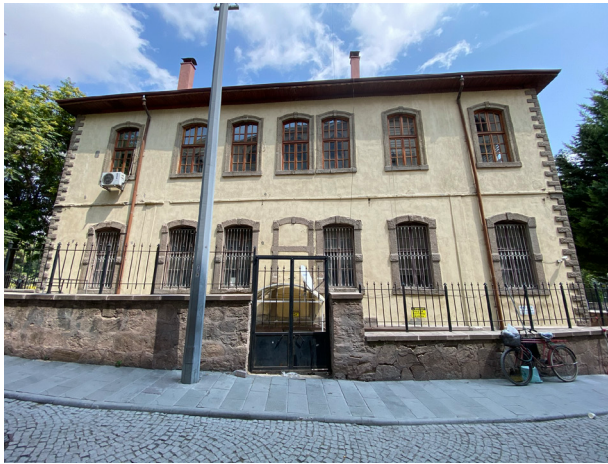
Fotoğraf 24: Halk Eğitim Merkezi Batı Cephe Genel Görünüm/ Photo 24: General View of the Western Facade of the Public Education Center
