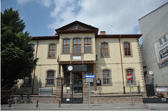
Fotoğraf 23: Halk Eğitim Merkezi Genel Görünüm / Photo 23: General View of the Public Education Center
