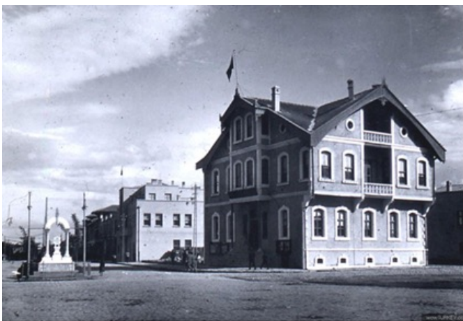
Fotoğraf 49: Eski Belediye Binası (Uz ve Doğan'dan) / Photo 49: The Former Municipality Building (from Uz and Doğan)
