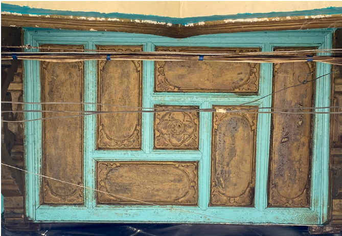
Fotoğraf 7: Arapoğlu Kosti Evi Çıkma Altı Tavanı / Photo 7: Ceiling Beneath the Projecting Bay of the Arapoğlu Kosti House
