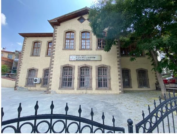
Fotoğraf 25: Halk Eğitim Merkezi Kuzey Cephe Genel Görünüm/ Photo 25: General View of the Northern Facade of the Public Education Center
