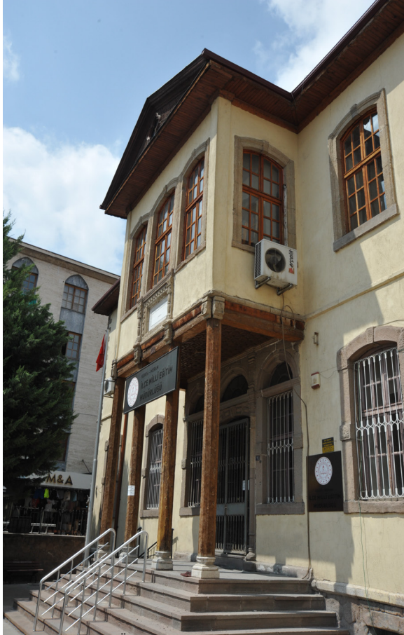
Fotoğraf 28: Halk Eğitim Merkezi Üç Cepheli Çıkma/ Photo: Three-Sided Bay Projection of the Public Education Center
